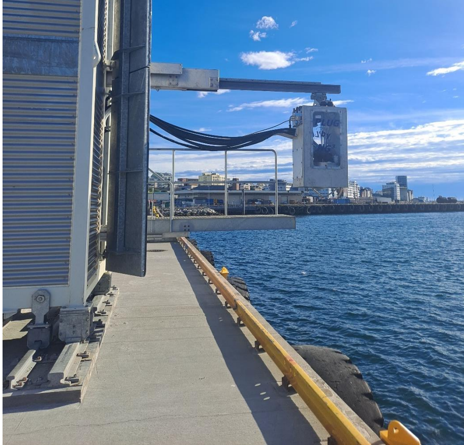
gangbro og Y-akse full ut-posisjon
